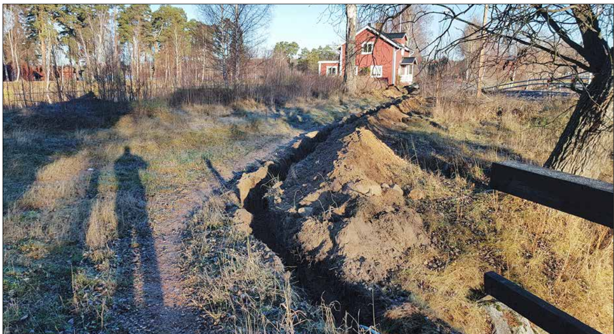
Figur 6. Foto över kabelschaktet förbi gravfältet Torsång 26:1. Foto mot N.
