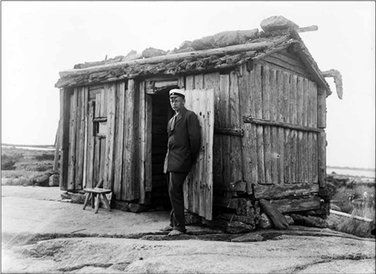
Figur 13. Fiskarstuga från Sydösterbotten, från "SLS 235 Sydösterbottniska allmogebyggnader (1914)". Stugan är en enkel ryggåsstuga med en framkammare/oisolerad hall (till höger) och stugan med eldstad till vänster. Berget utgör golv i hallen. Även om bilden är från en helt annan del av Skandinavien påminner planen om lämningen L2019:1531. Lämningen skulle kunna varit en liknande stuga, men där berget utgör ena väggen.
