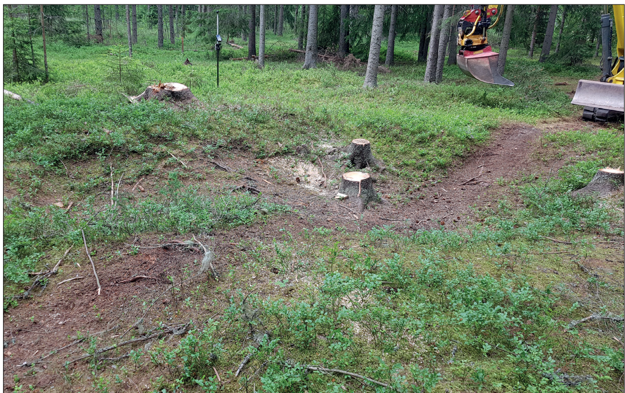
Figur 23. De stora stubbarna efter granar blev ett problem vid schaktningen även vid Gustafs 239:3. Arbetsbild, foto mot nordöst.
