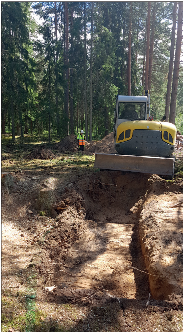
Figur 20. Arbetsbild över schaktet igenom Gustafs 239:1 och 239:2. De stora stubbarna försvårade grävningen av schaktet.
