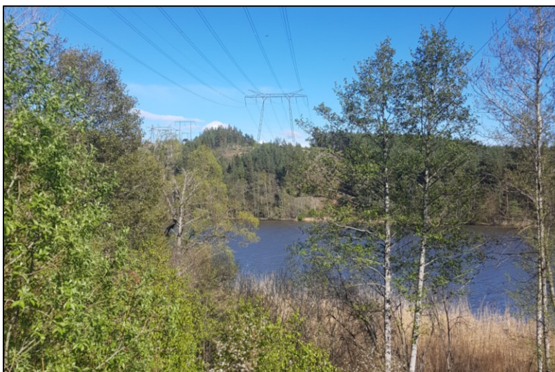
Figur 4. Den planerade kraftledningen kommer passera över Ryssviken, liksom de befintliga kraftledningarna gör idag. Foto mot öster.
