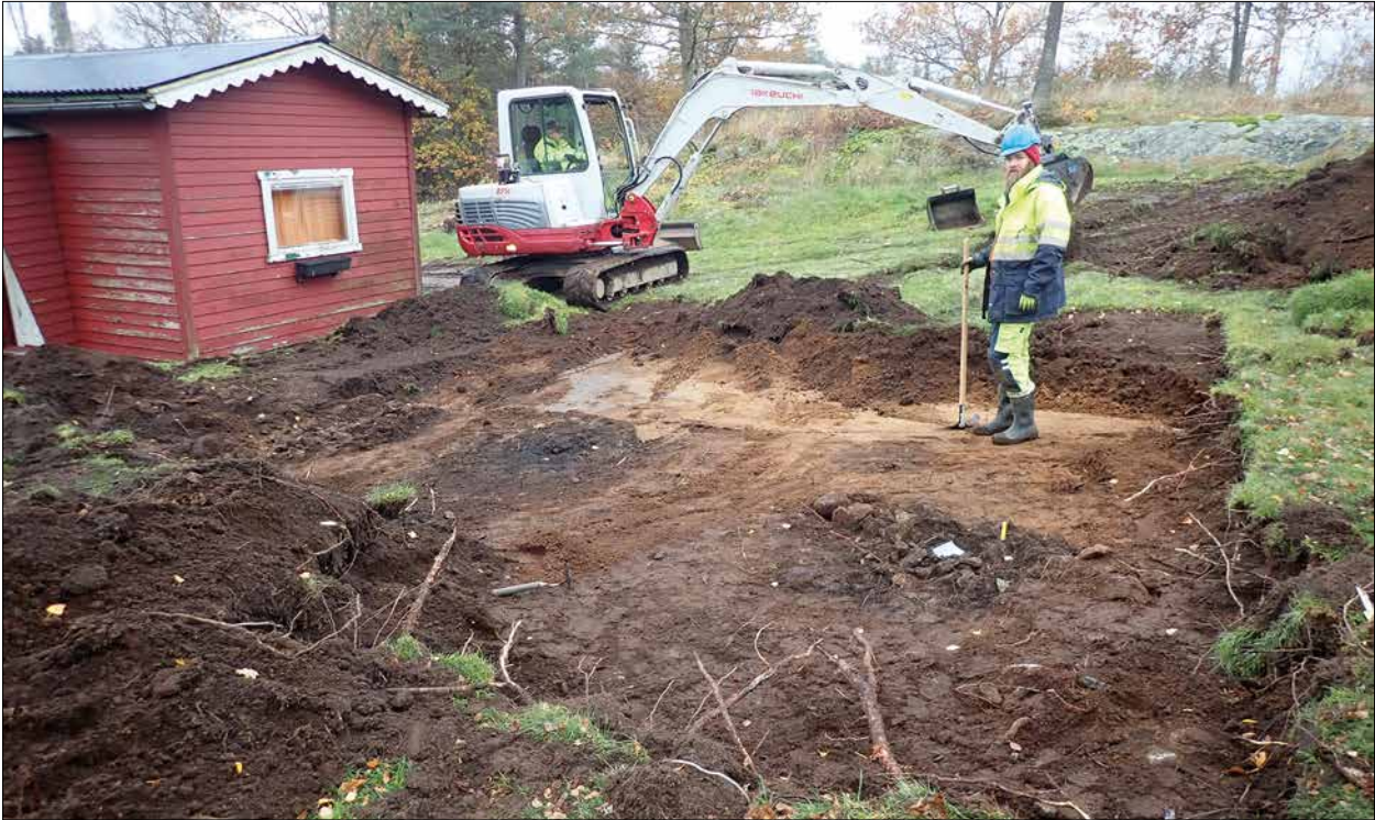
Figur 5. Arbetsbild när schakt 15 och anläggningarna A2-5 rensas fram. Foto mot nordväst.
