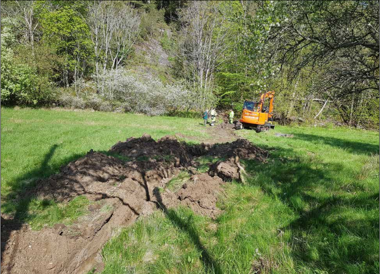
Figur 10. Kabelschaktet genom boplatsen L1938:3046. Fotoriktning mot norr.
