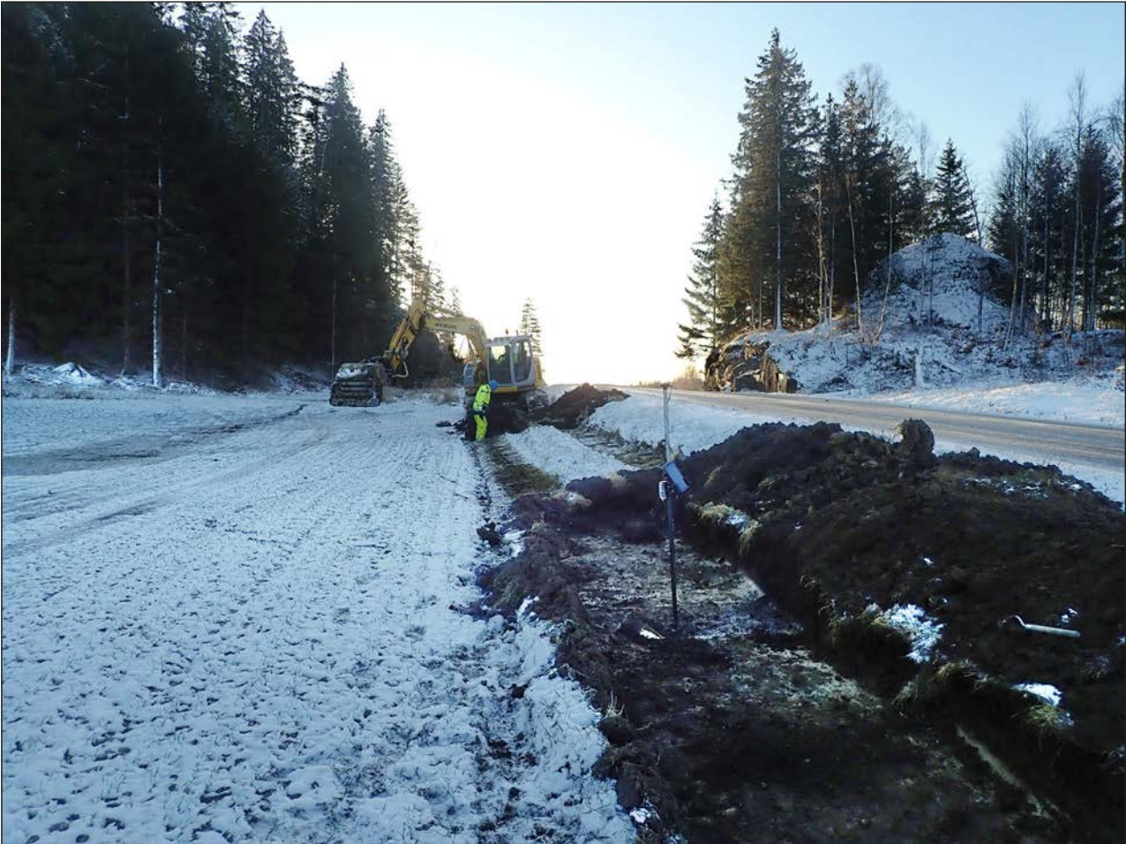
Figur 15. I den norra delen av utredningsområde 4 var åkermarken nyligen plöjd och sådd och bärigheten bedömdes mycket dålig efter höstens omfattande regn. Schakten grävdes därför intill vägen. Arbetsbild där Daniel Gunnarsson dokumenterar schakt 78, foto mot söder.
