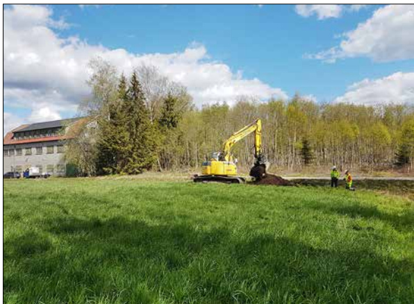
Figur 7. Utredningsområde 15, arbetsbild mot öster med industribyggnaden i bakgrunden.
