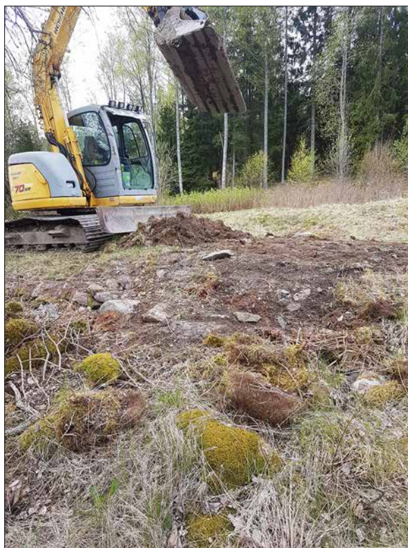
Figur 13. Arbetsbild när husgrunden L2020:6444 avtorvas med grävmaskin. Foto mot sydväst.
