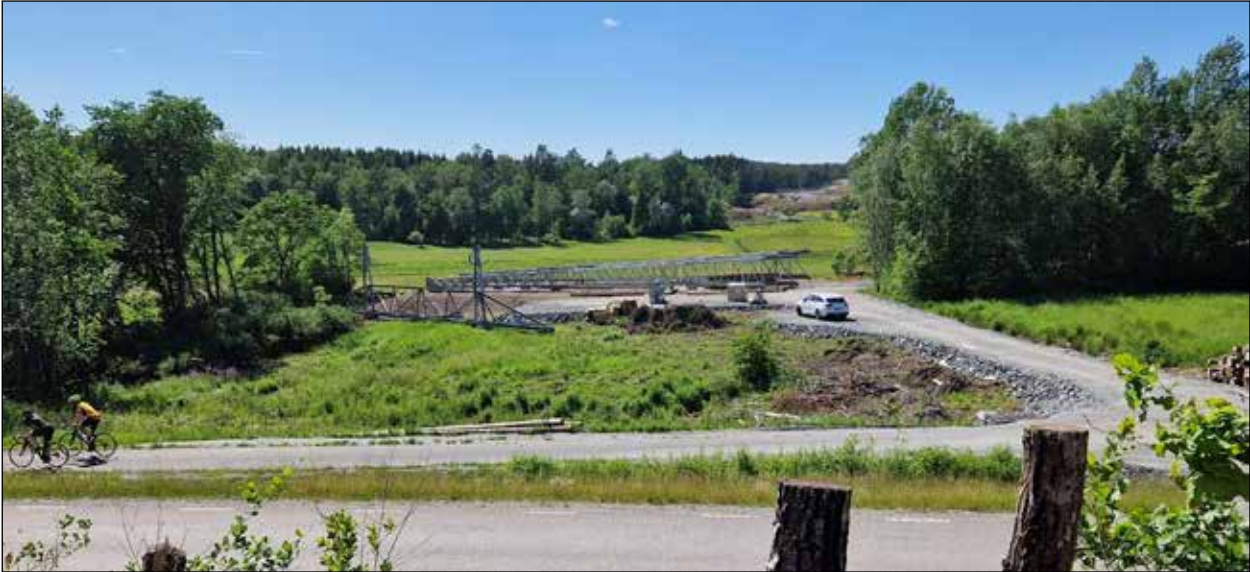
Figur 15. Lottabackens gamla tomt, L1959:1905. Omfattande markarbeten har genomförts på tomten och fotot är taget strax innan att en kraftledningsstolpe ska resas på platsen. Idag är framförallt resterna av ekonomibyggnaden på tomtens norra del som är synliga på platsen, i bilden skymda av träden t.h. I bakgrunden syns den nyröjda kraftledningsgatan för Ingelkärr–Stenkullen, vilken tangerar utredningsområdets södra sida. Fotoriktning mot väst.
