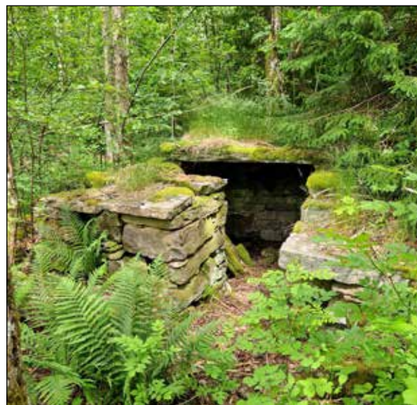
Figur 14. Ingången till en jordkällare på Ljungslätts gamla tomt, L1964:4646. Jordkällaren är uppbyggd med huggna stenar och har, liksom de andra synliga byggnadslämningarna på platsen, sannolikt tillkommit på 1800-talet. Fotoriktning mot nordöst.
