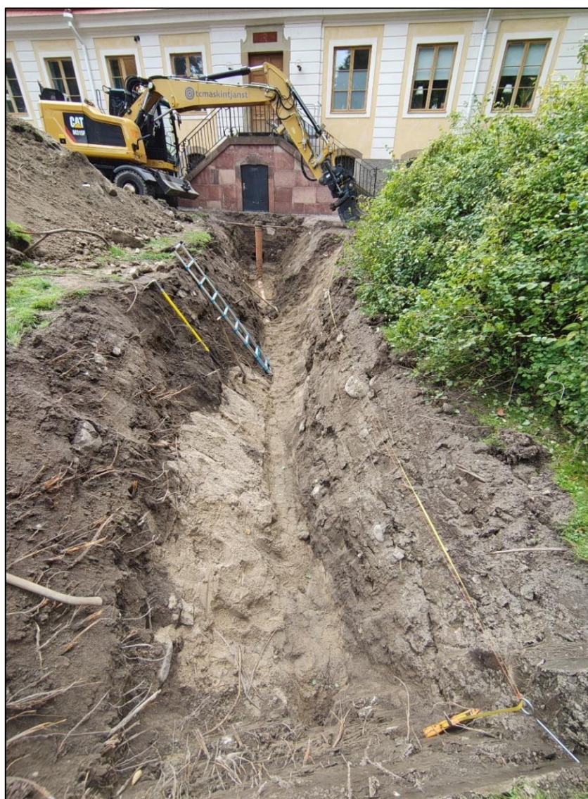
Figur 2. Foto över ledningsschaktet i samband med profilritning. Fotoriktning mot väst.
