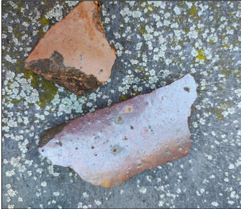
Figur 7. Rester av äldre generationer avloppsrör och taktegel.
