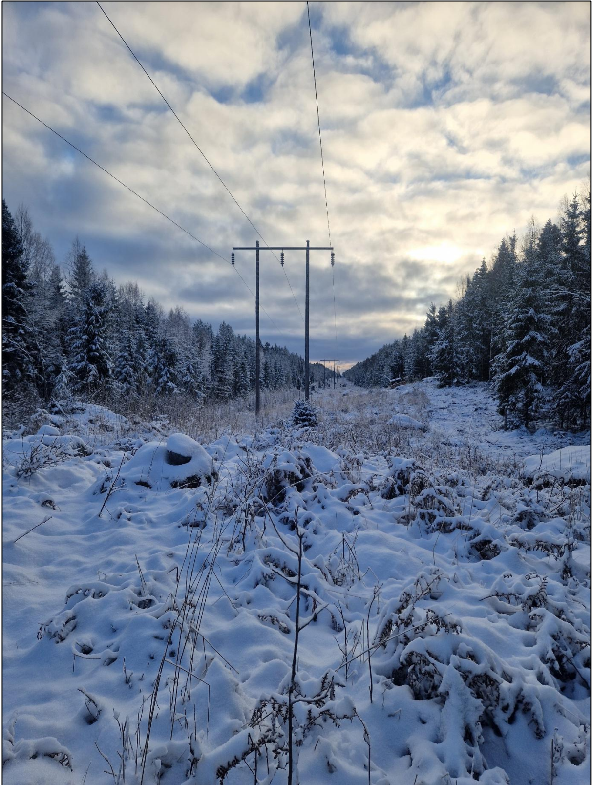
Figur 2. Översiktsbild söder om Krylbo med utsikt över inventeringskorridoren och den befintliga kraftledningen mot sydost.
